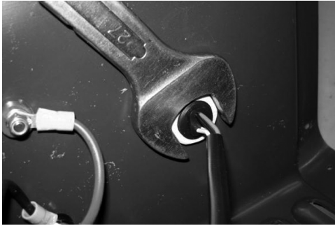
Abbildung 6: Festziehen der Muffe
